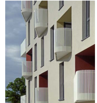
Schmiedeeiserne, gerundete Brüstungen zitieren leicht nostalgisch die Geländer von Gründerzeitbalkonen bei den Loggien der innovativen Wohnbebauung in Kempten Foto: Archiv F64 Architekten
