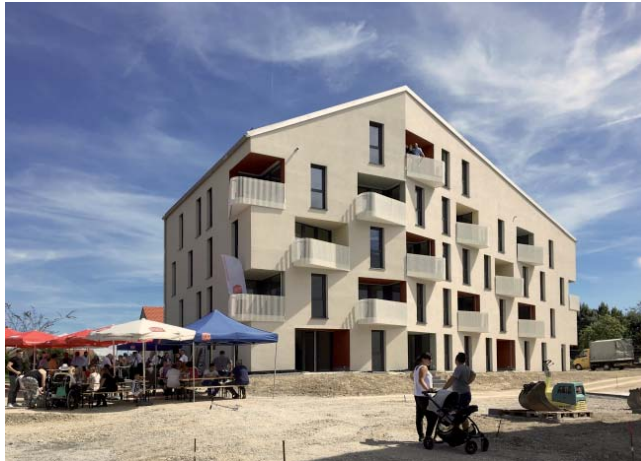
Fest zur Fertigstellung des 1. Wohngebäudes/Ludwigshöhe-Sligostrasse im Sommer 2016 Foto: Archiv F64 Architekten
