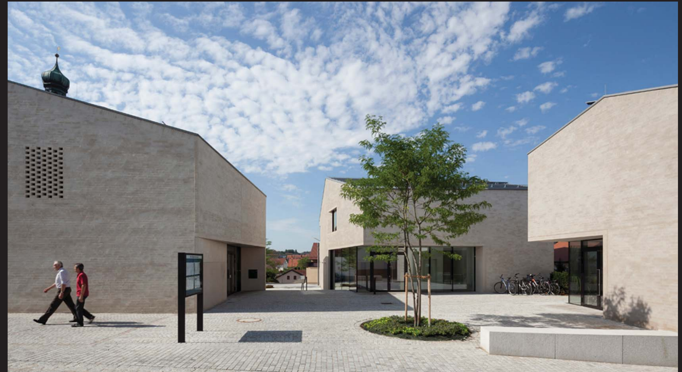
BEMBÉ DELLINGER ARCHITEKTEN | GREIFENBERG RATHAUS + NEUE ORTSMITTE WETTSTETTEN
